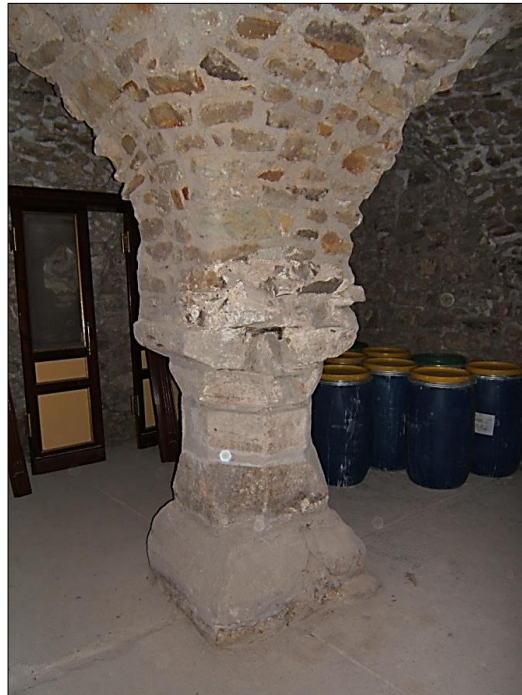
Kellergewölbe im „Goldenen Pflug“
